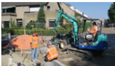
Ijpelaar Rioleringswerkzaamheden Gemeente Breda/Van den Elshout & De Bont
