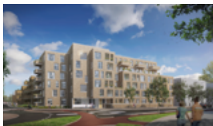
Nieuwbouw Zuiderspoor Enschede 45 appartementen + 15 woningen Woningcorporatie Domijn
